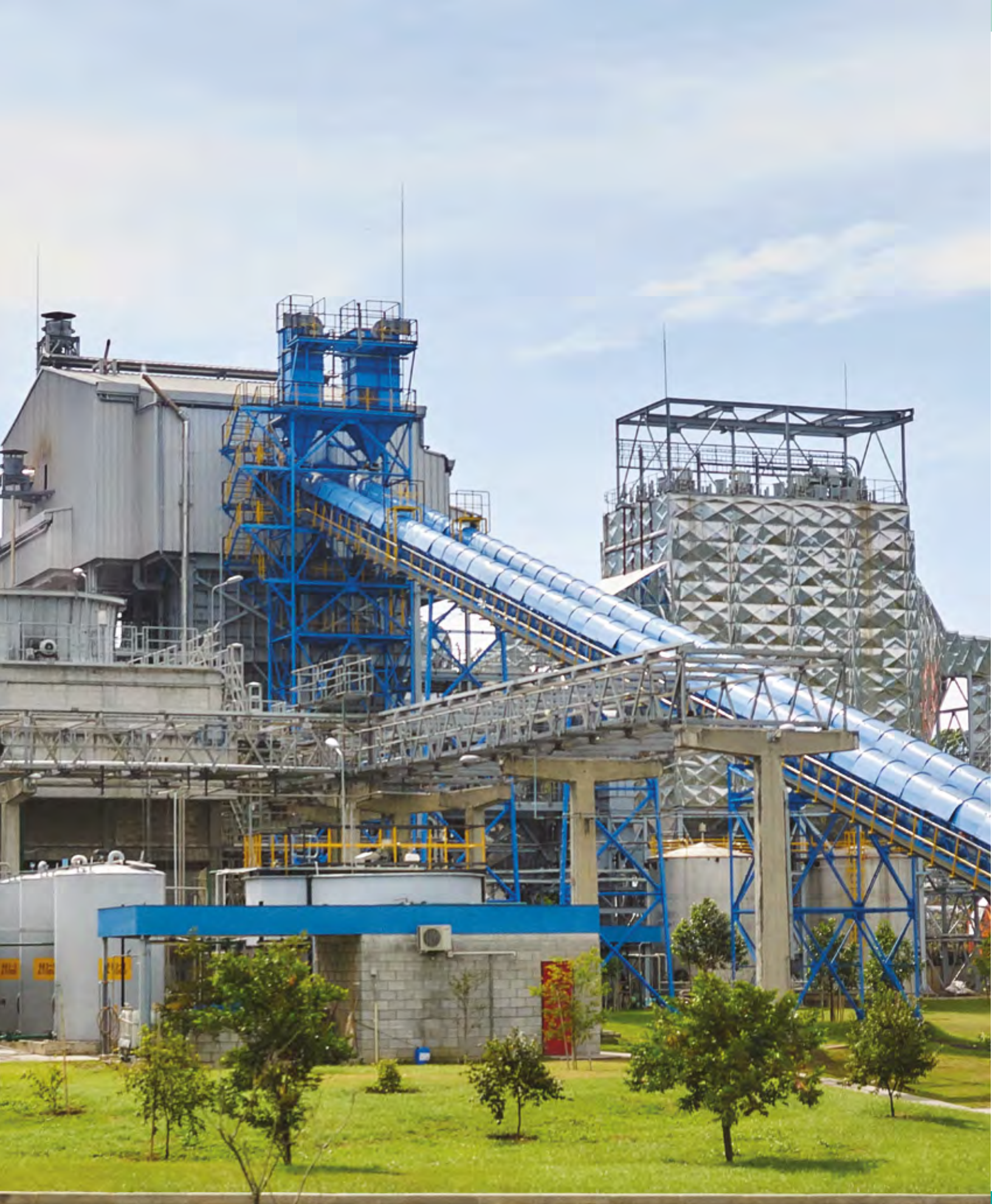
PLANTA DE GENERACIÓN DE ENERGÍA
